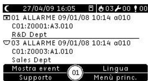
Figura 4: Indicazione di allarme incendio sul display LCD della centrale
